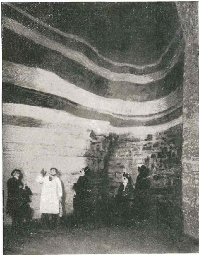
CLOCHIF DE FONTIS SOUS LA RUE DAREAU
